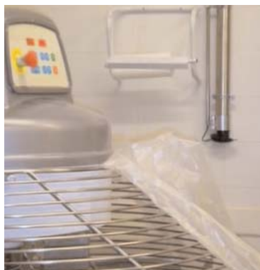
Preso di aspirazione ad alta pressione dotata di valvola di chiusura.
