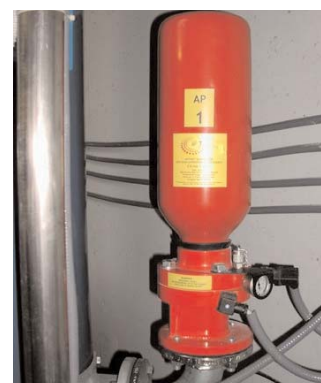
Particolare del dispositivo "Antidet Suppressor" montato sul gruppo-filtro EPK.
